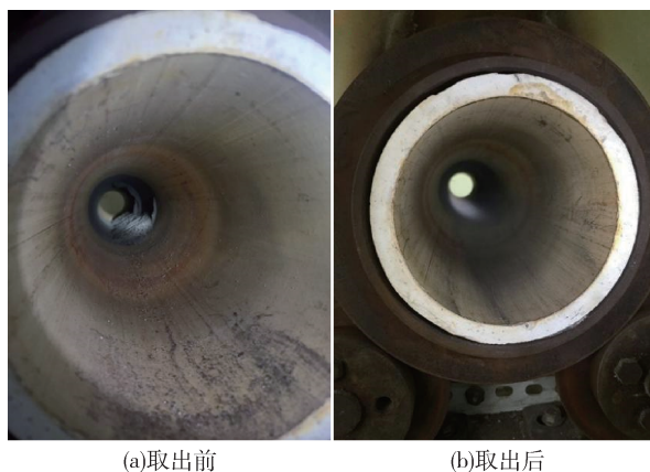
图6 回转窑渣取出前后窑内情况
